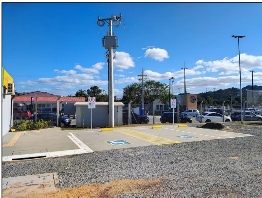
Figura 9: Vagas PNE e de Idoso sendo implementadas, com sinalização horizontal e vertical no empreendimento.
